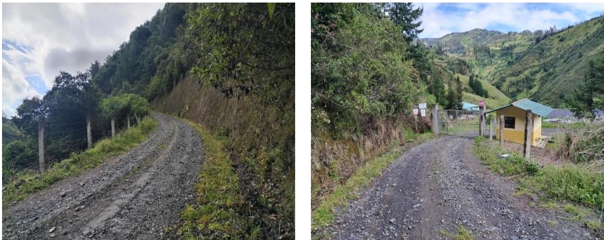
Fotografía N° 1.- Vías de acceso
