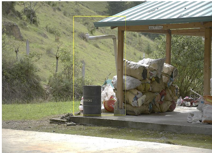
Fotografía N° 12.- Drenaje de agua lluvia
