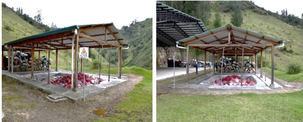
Fotografía N° 6.- Celdas para distribución de desechos sanitarios
