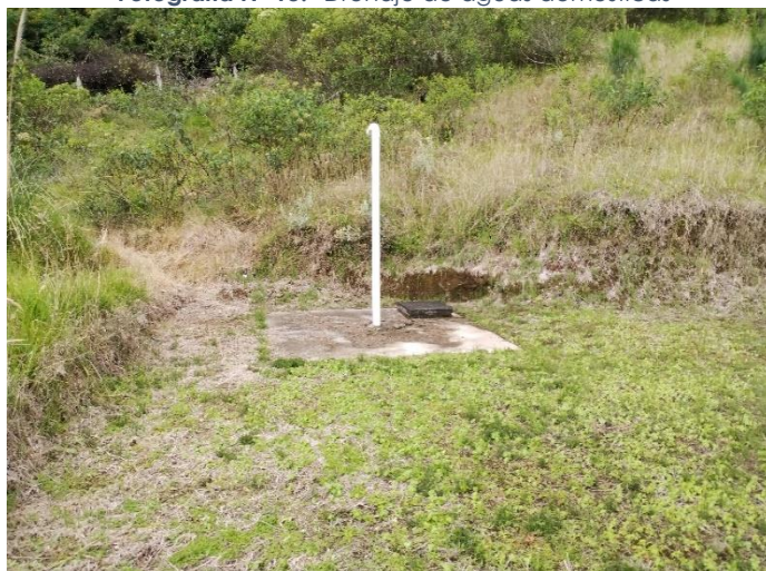
Fotografía N° 13.- Drenaje de aguas domésticas
