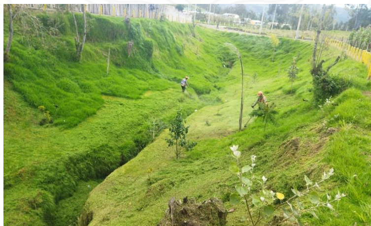
Imagen 18. Mantenimiento de las quebradas Mallacoa y Ermita.
